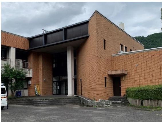
改修される公民館（旧林業センター）
