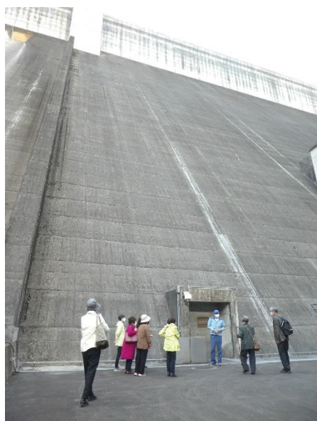
大山ダムの見学。この後、ダムの中も見せてもらいました。
