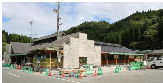
改装工事の様子(10月11日現在)
