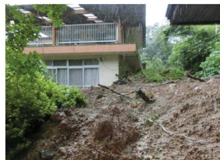
1階部分に押し寄せた土砂
