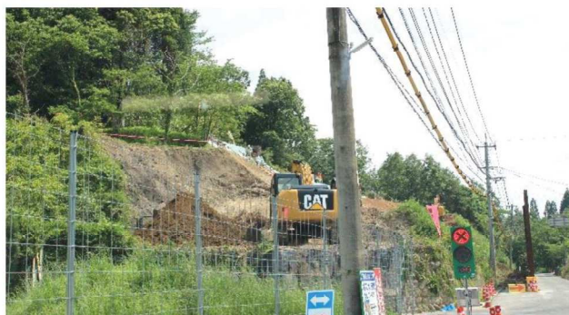
現在復旧工事を進めています
