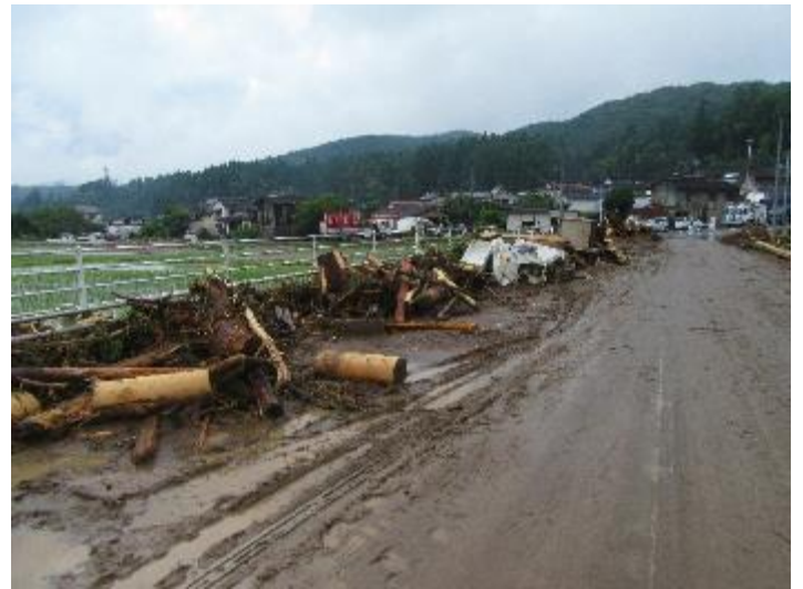
山田川の氾濫で、水の流れ道になった場所です。流木はガードパイプに引っかかり道路を埋め尽くしています。(山田町県道交差点付近)
