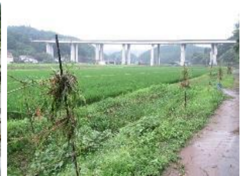
防護柵の柱に引っかかった草。この高さまで水位があったことがわかります。(二串町付近)
